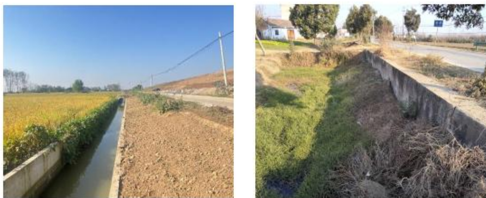
图 2-3 现状排水和防护设施（左：排水设施，右：挡墙防护设施）
