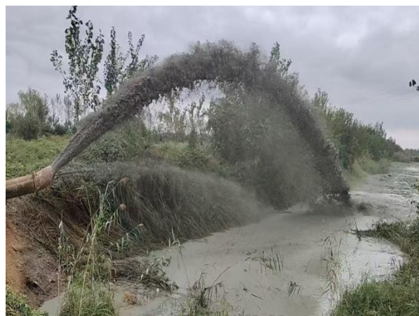
疏浚弃土吹填
