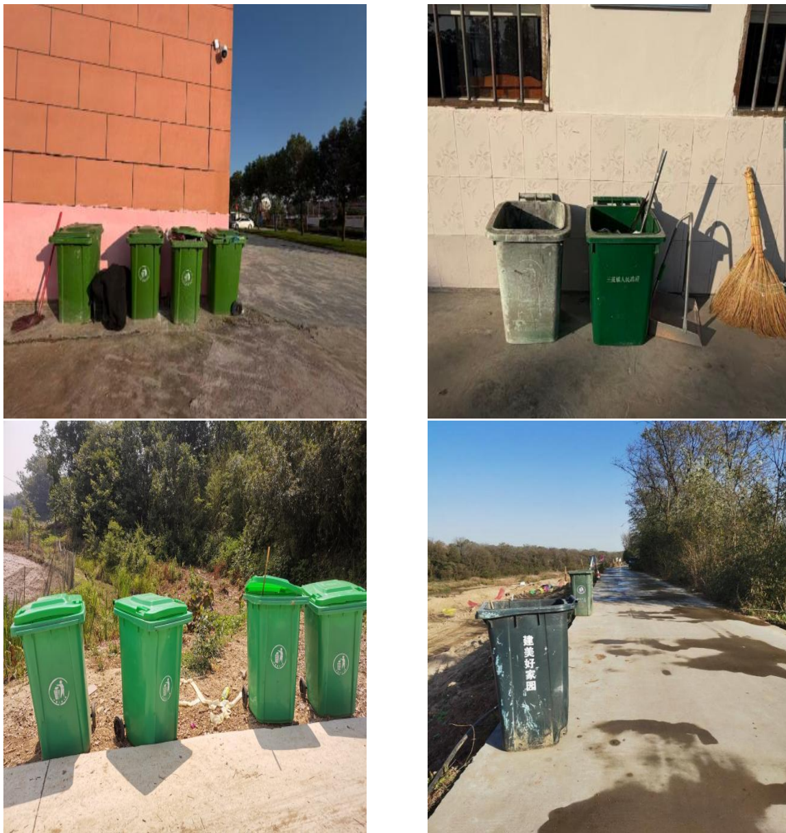
图7.3-1 施工现场及项目部垃圾桶
