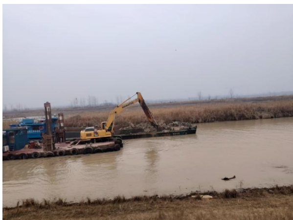
岸坡土方开挖
