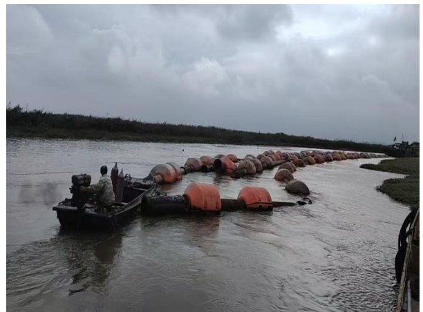
输泥管道敷设
