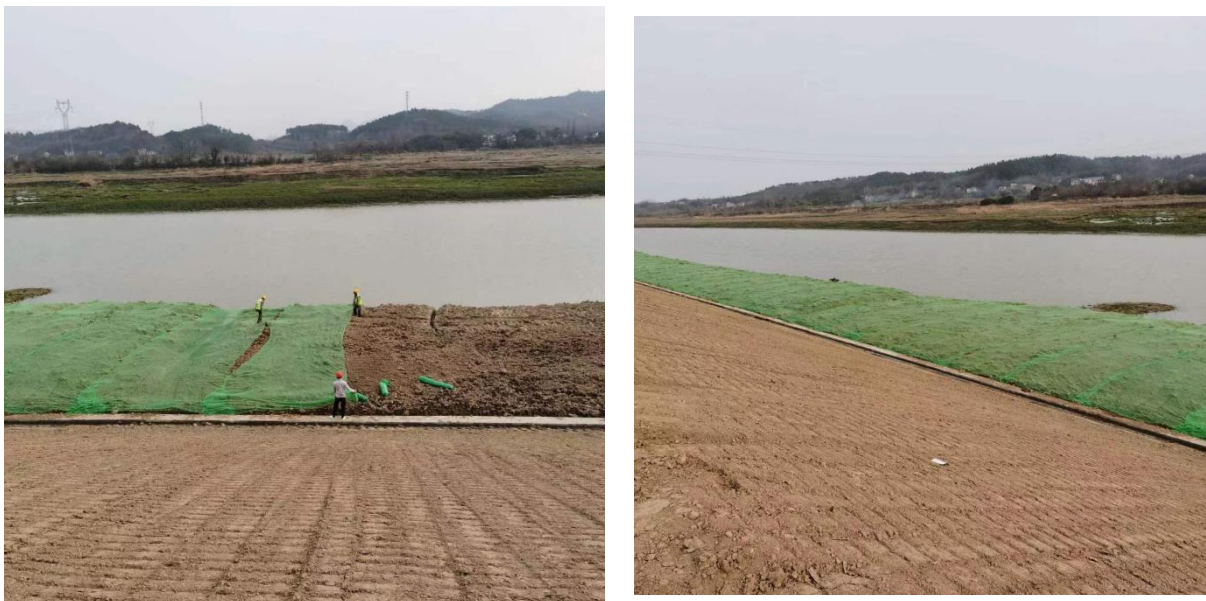
施工现场防尘网覆盖
