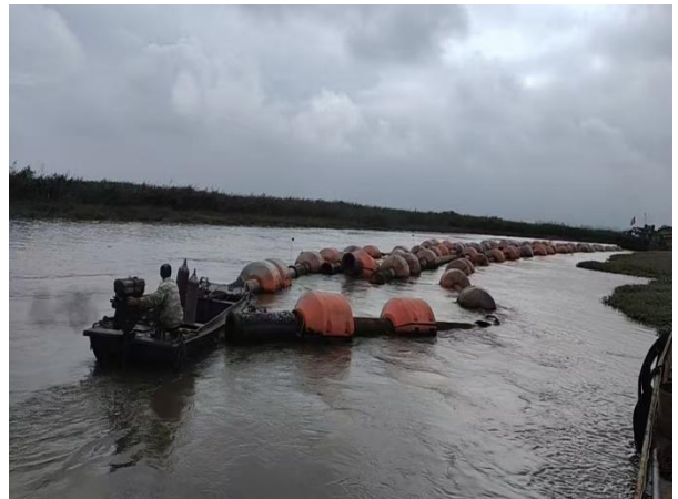
输泥管道敷设
