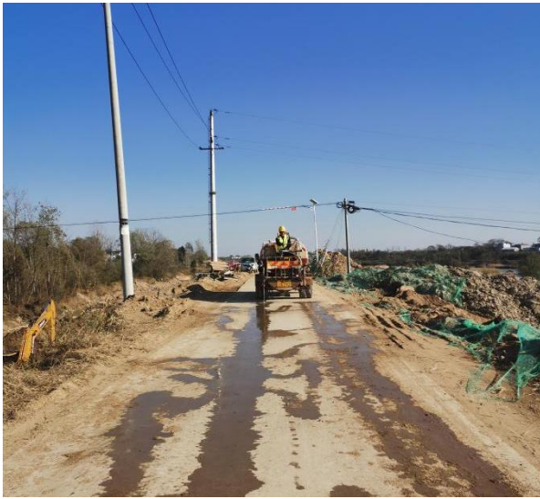
施工现场洒水降尘
