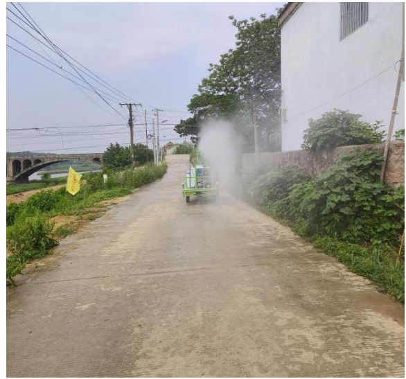
施工现场洒水降尘
