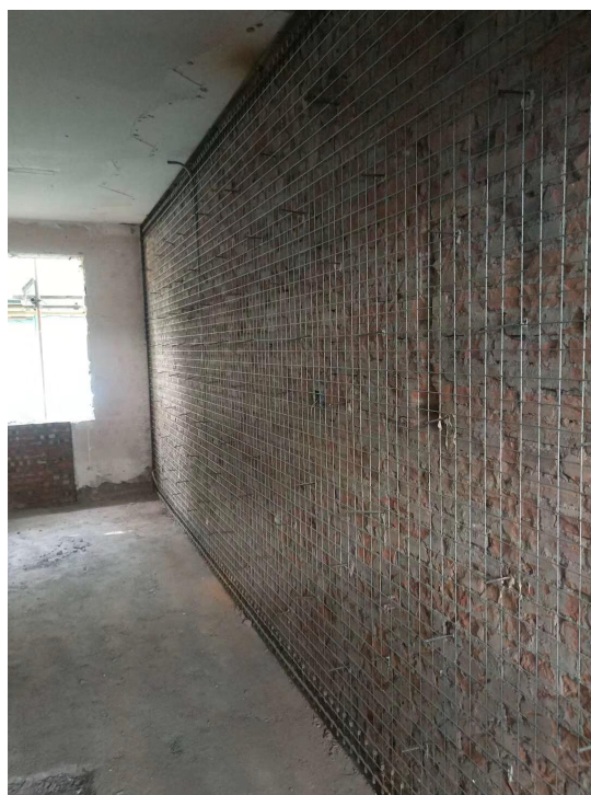
外加钢筋网-砂浆面层
