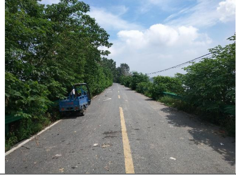
二里涧桥下游沿岗堤堤顶道路
