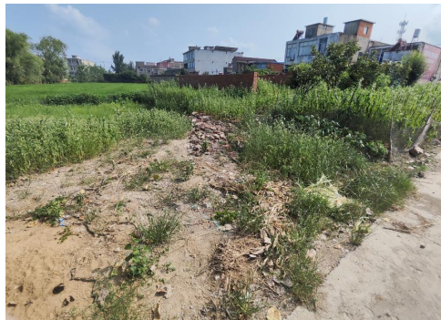
图 3-17 现状渠道杂草丛生、淤积严重
