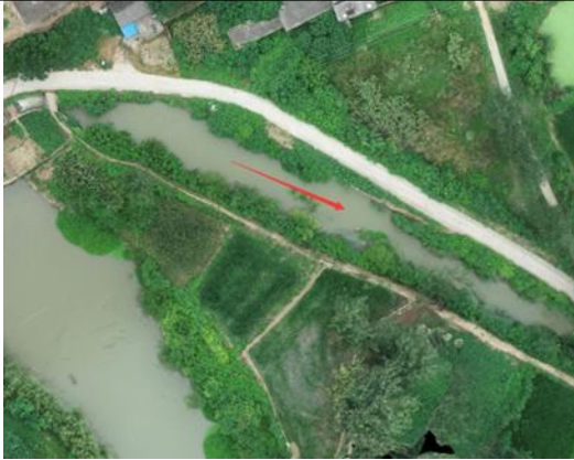
图3-11 陈东支渠部分淤积
