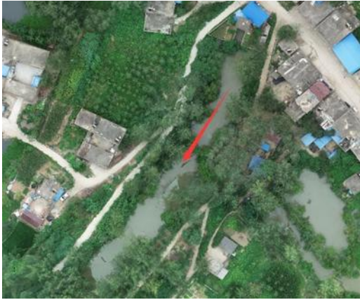
图 3-7 临王段干渠起点
