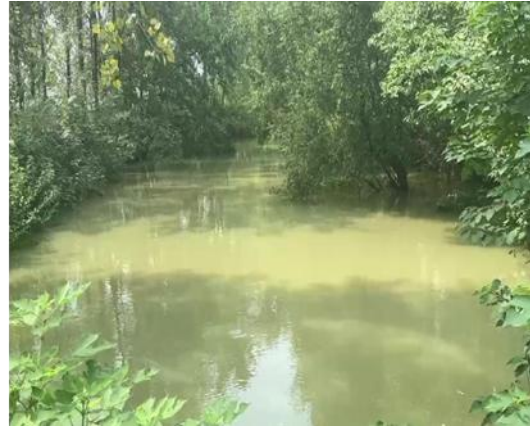
图 3-8 临王段干渠杂草丛生
