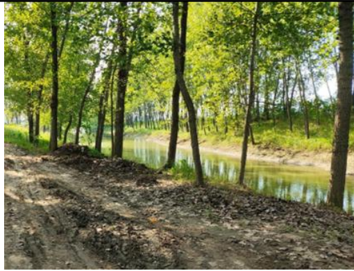
图 3-15 引水渠渠身杂树丛生
