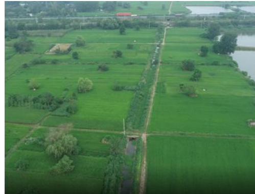
图3-14 未衬砌渠道现状渠道淤积
