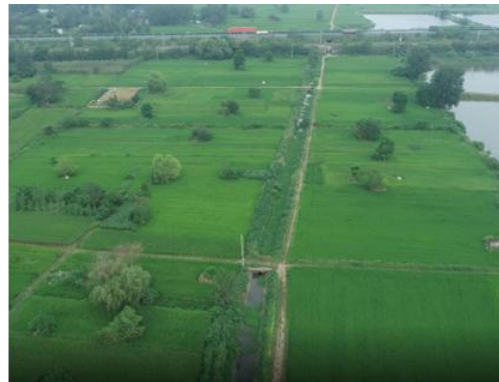
图3-8 未衬砌渠道现状渠道淤积
