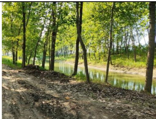
图 3-9 引水渠渠身杂树丛生
