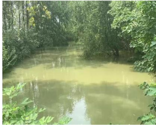
图 3-2 临王段干渠杂草丛生
