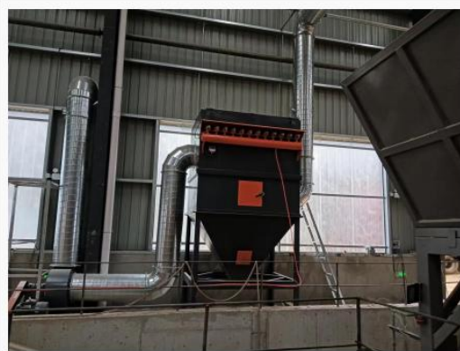
制砖产线布袋除尘器
