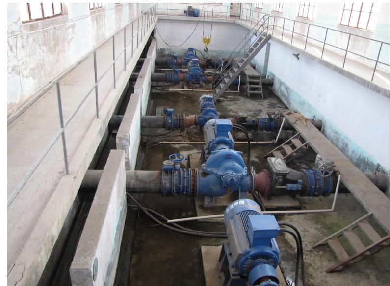
数  $Q=1520\text{m}^3/\text{h}$ ,  $H=41\text{m}$ ,  $P=250\text{kW}$ , 小泵参数  $Q=760 \text{ m}^3/\text{h}$ ,  $H=41\text{m}$ ,  $P=160\text{kW}$ 。
